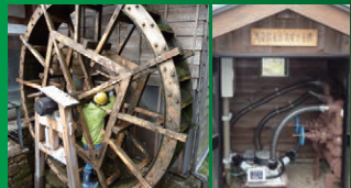
施工例:馬籠宿水力発電2号機
