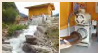
施工例: 上松町滑川小水力発電所
