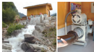
施工例: 上松町滑川小水力発電所
