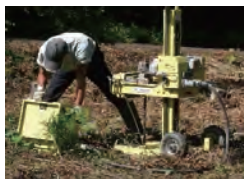
地盤調査の様子
