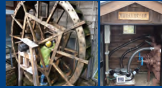
施工例:馬籠宿水力発電2号機
