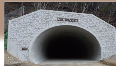
当社施工 和村トンネル工事(上松町～大桑村)
