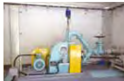
施工例:南木曾町細ノ洞発電所 令和2年12月竣工
