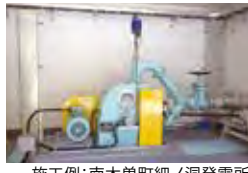
施工例:南木曾町細川洞発電所 令和2年12月竣工
