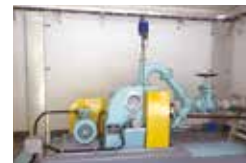
施工例：南木曽町細・洞発電所 令和2年12月竣工
