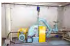
施工例: 南木曽町細ノ洞発電所 令和2年12月竣工
