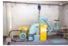
施工例:南木曾町細ノ洞発電所 令和2年12月竣工
